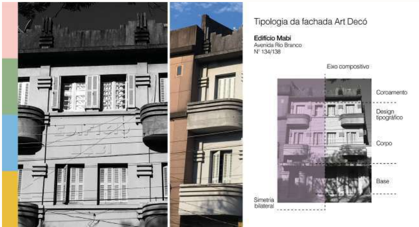
Figura 13: Detalhes do Edifício Mabi, arquitetura em estilo Art Decó
